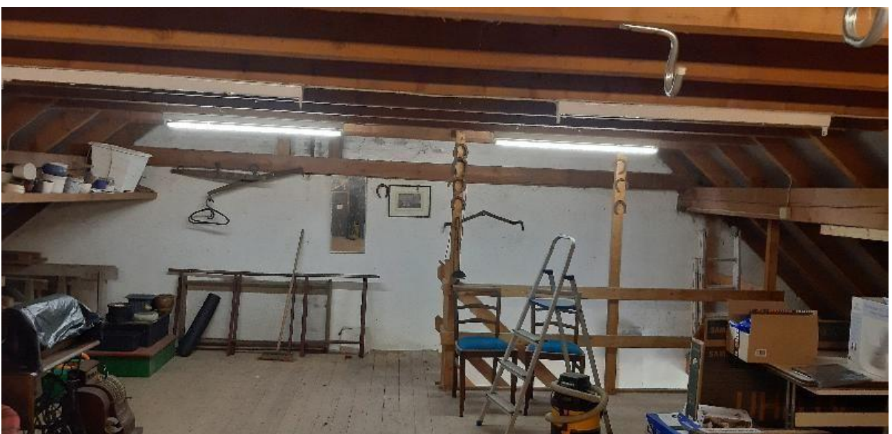
Dachboden im Hinterhaus
