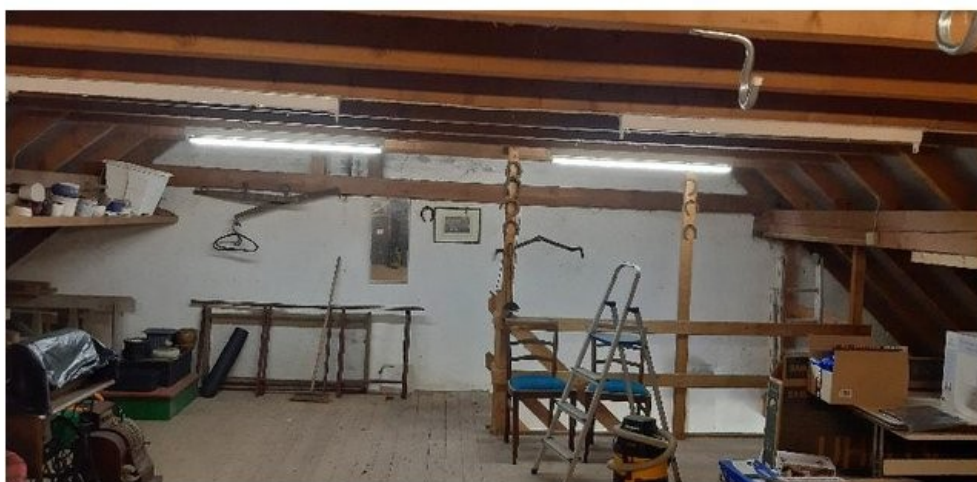
Dachboden im Hinterhaus
