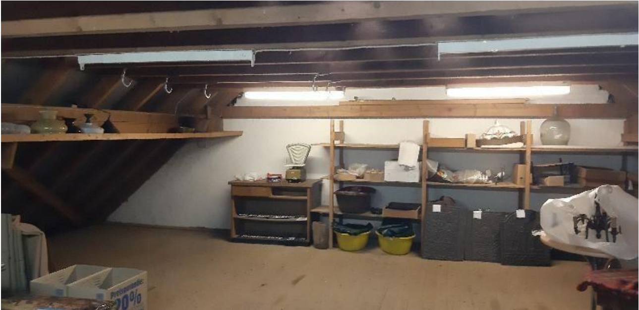
Dachboden im Hinterhaus
