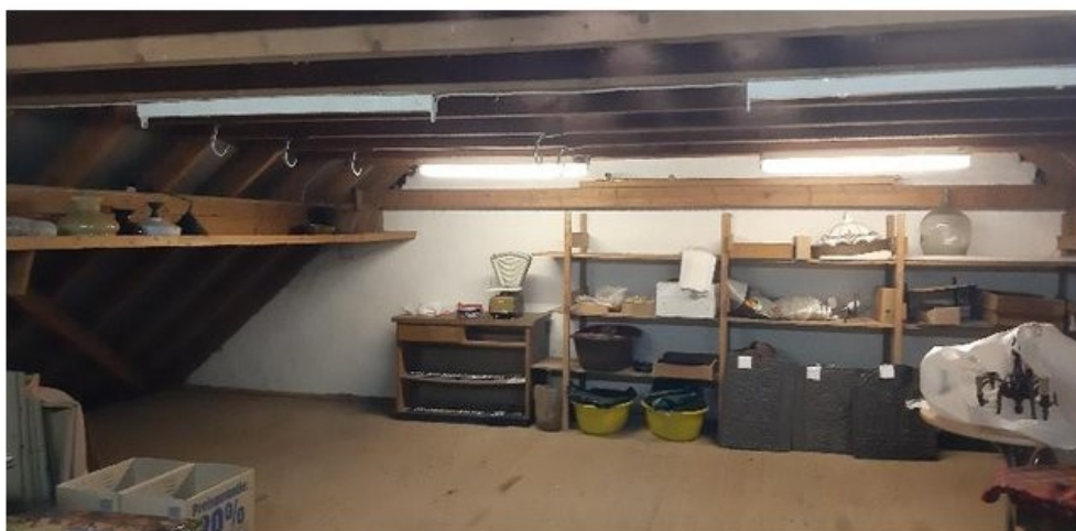
Dachboden im Hinterhaus
