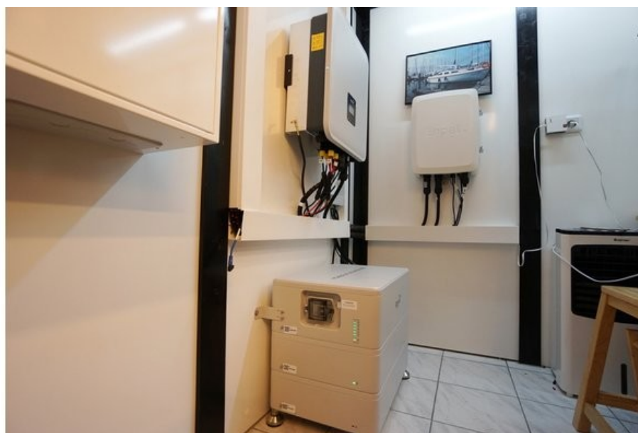
Batteriespeicher
