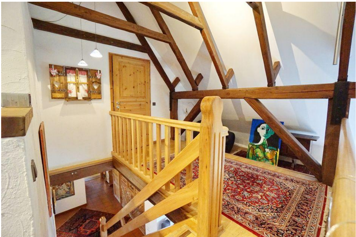
Zugang zum DG
