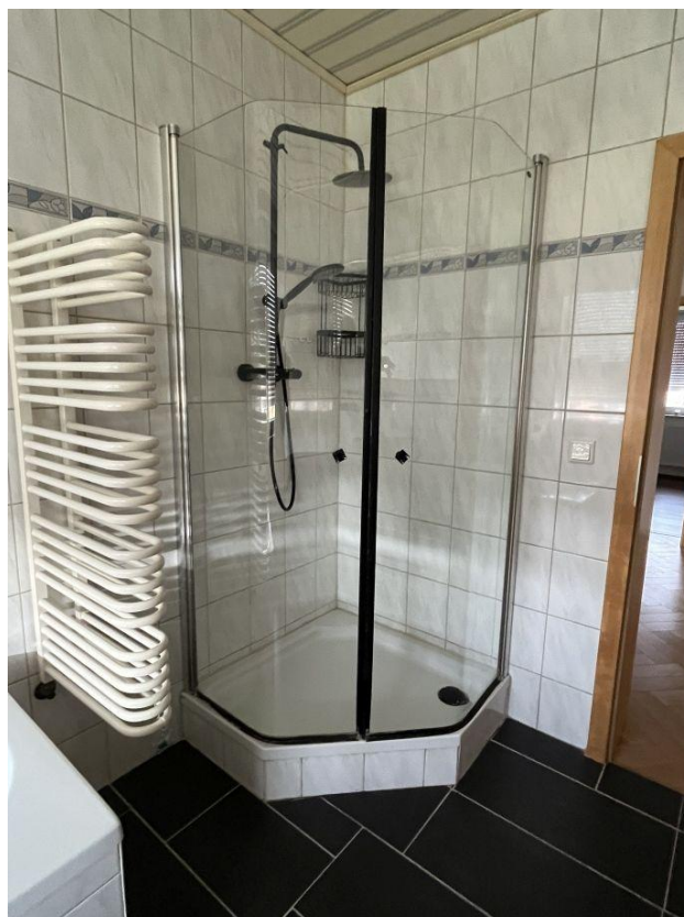
... und Dusche 1.OG
