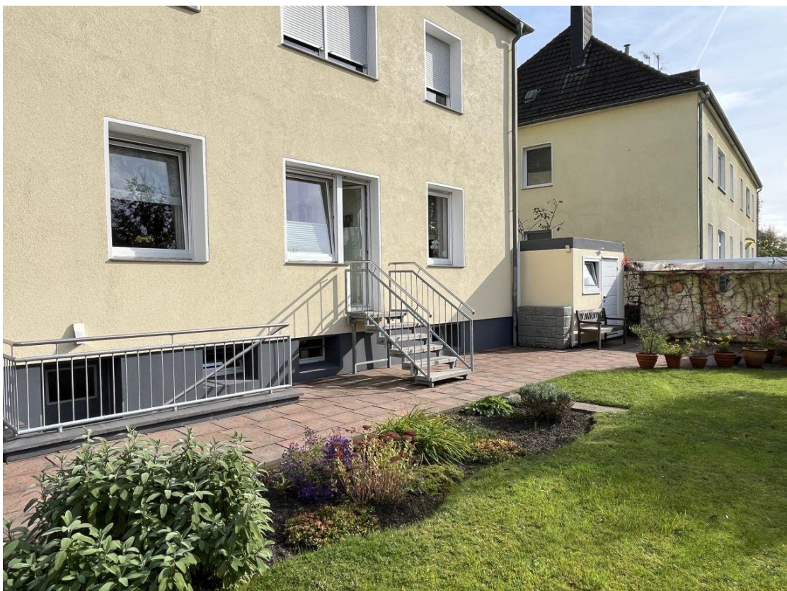
Terrasse und Zugang zum Garten
