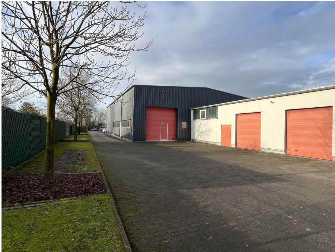
Außenansicht Halle I und II
