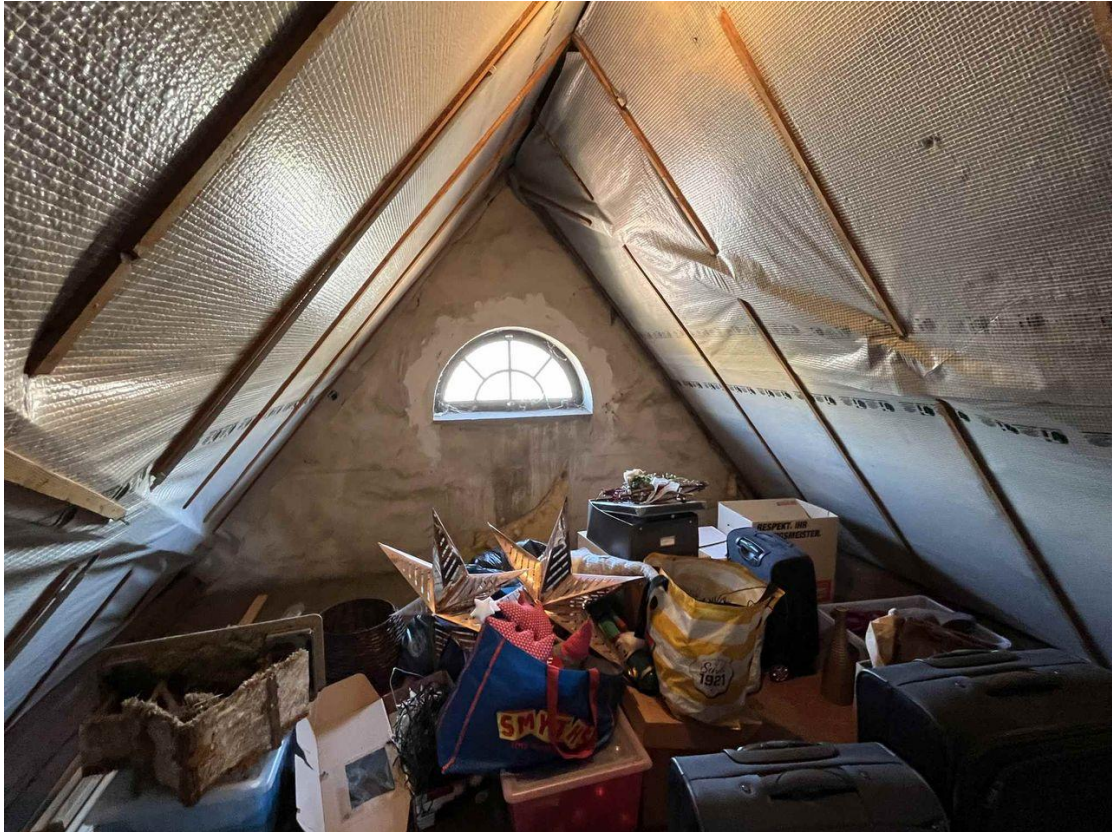
Speicher im Spitzboden
