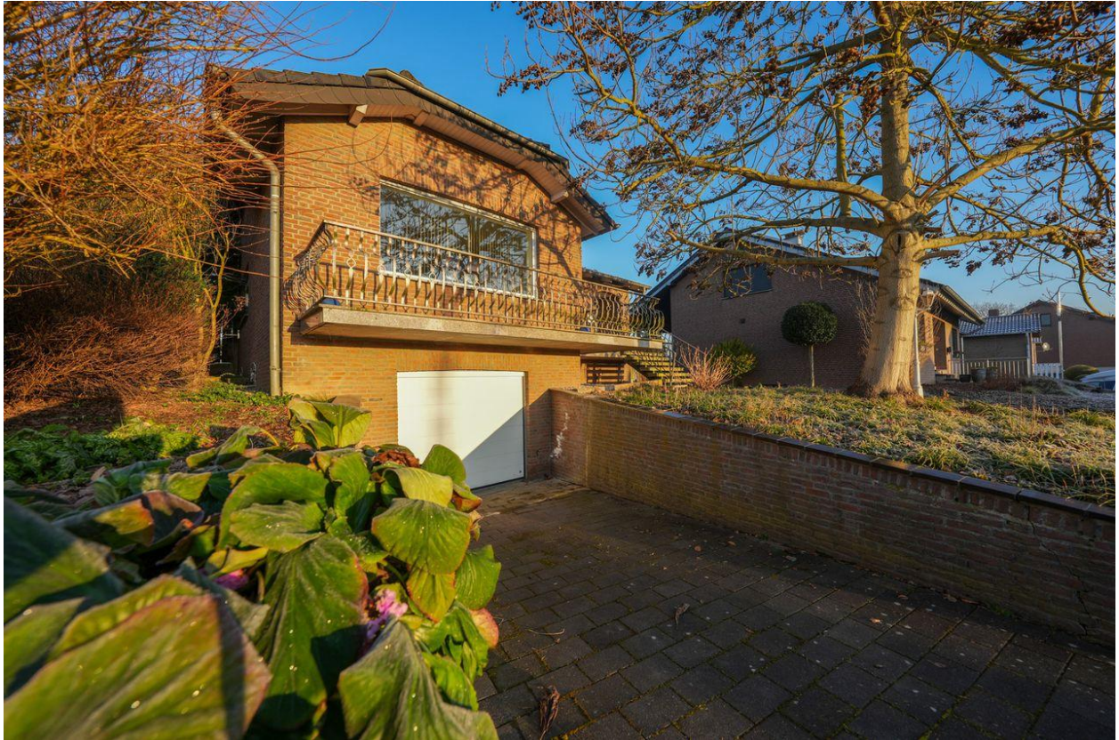
Zufahrt in die Garage
